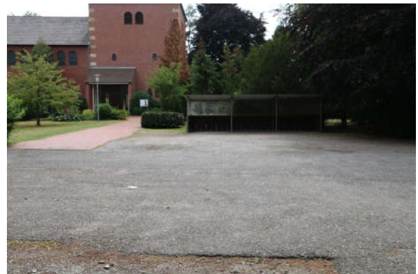
Abb. 27 Parkplatzbereich an der kath. Kirche St. Michael
